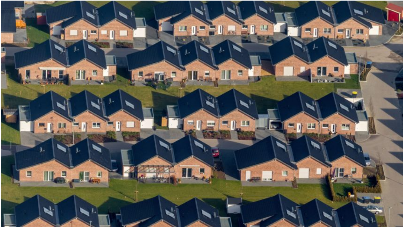
Die meisten Neubauviertel, die zur Zeit in Deutschland entstehen, sind langweilig, ökologisch fatal und wenig zeitgemäß. Foto: imago
