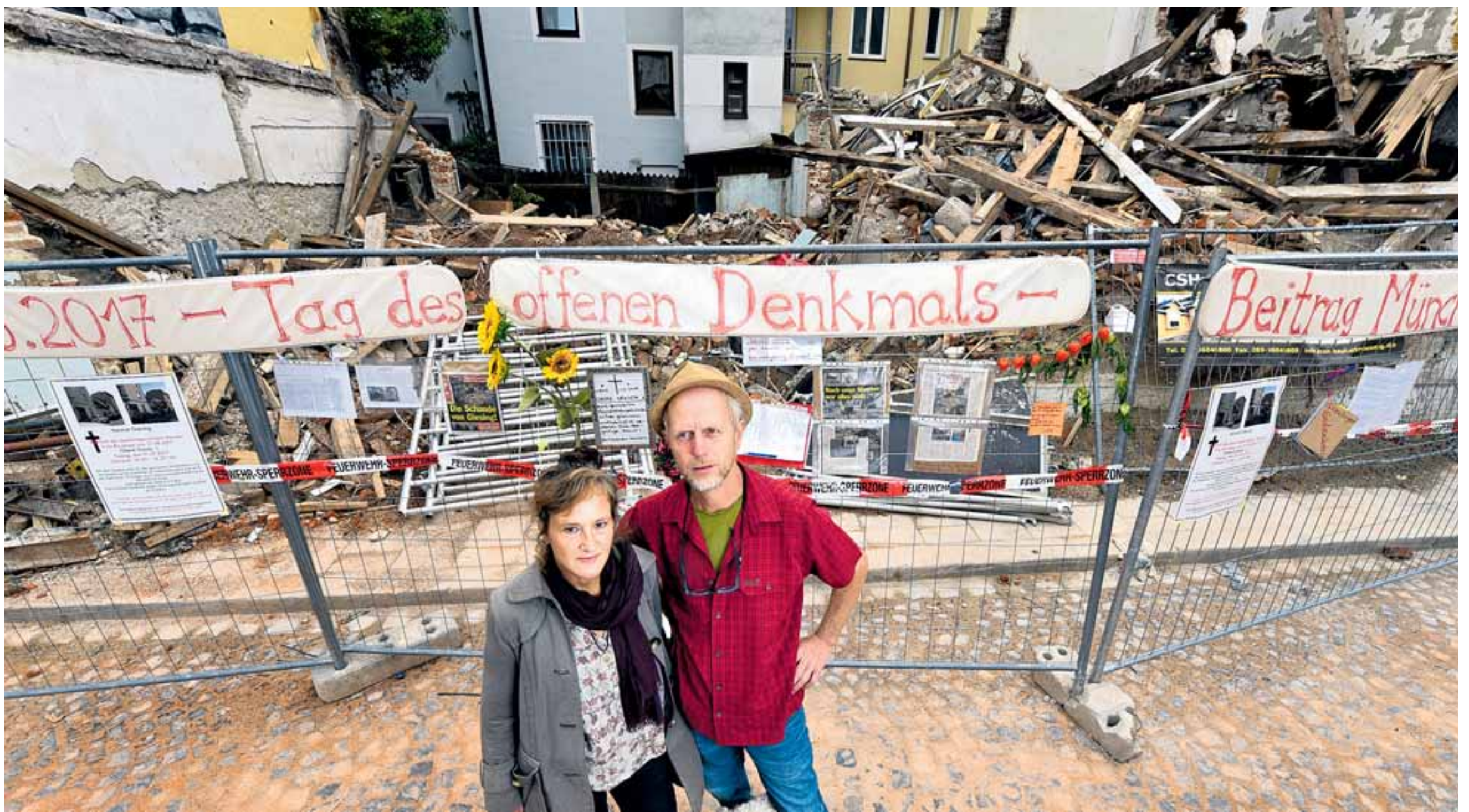
„Das ist doch Hohn“, sagen Monika Maier und Michael Seitz, die um die Ecke wohnen. München hat jetzt nur noch 45 geschützte Handwerkerhäuser – und ein beschädigtes Denkmal. So nennen sie den Schutthaufen offiziell. FOTO: CATERINA HESS
