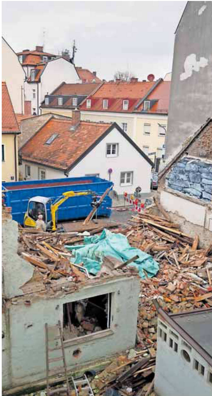
Das denkmalgeschützte Haus in Obergiesing war am 1. September eingerissen worden. Nun werden die Reste weggeräumt und eingelagert. FOTO: ROBERT HAAS
