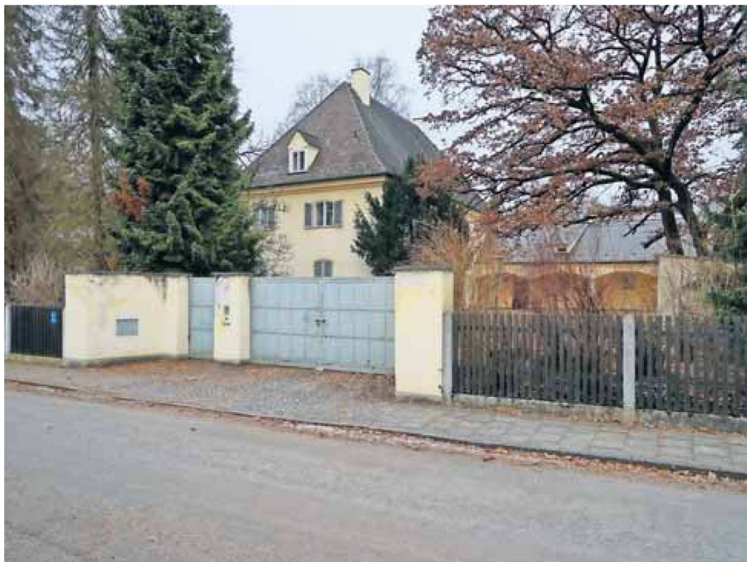
Platz da: Diese Villa aus den Fünfzigerjahren soll zugunsten der Neubauten abgerissen werden.
