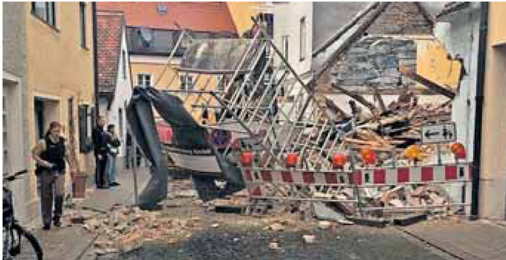
Binnen weniger Minuten dem Erdboden gleich gemacht: das ehemalige Handwerkerhaus in der Oberen Grasstraße 1.
